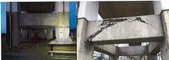
土木設備損傷(高架橋)
