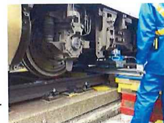
復旧作業の様子
