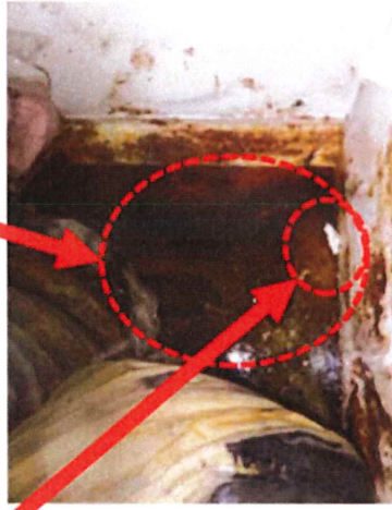
図4. コンテナ内部の状況
