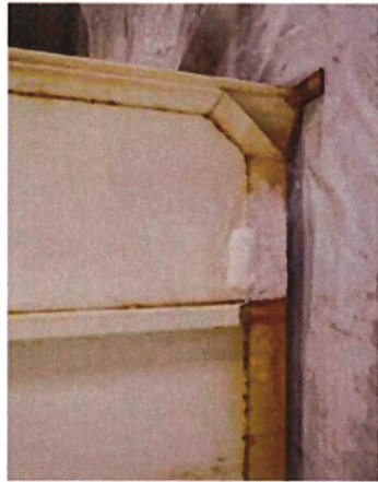
図1. 腐食箇所の補修箇所
