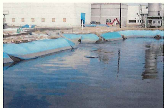
写真 応急復旧の事例（仮設沈殿池・素堀）
